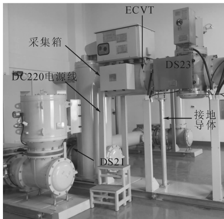
图4 电缆出线间隔智能化GIS
