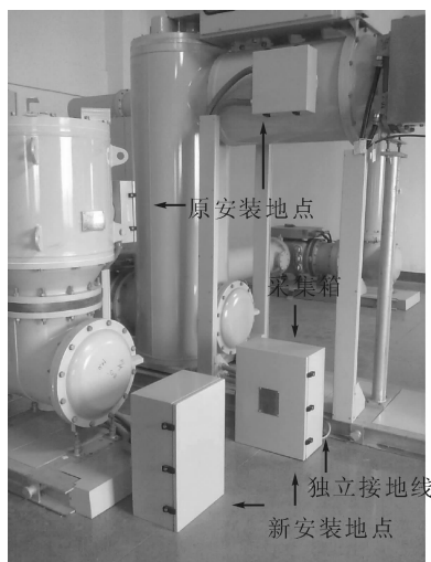
图 6 采集箱对立就地安装
